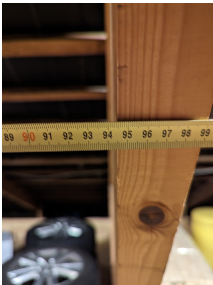
Figure 18: Afstand imellem spær, 94,5cm.
