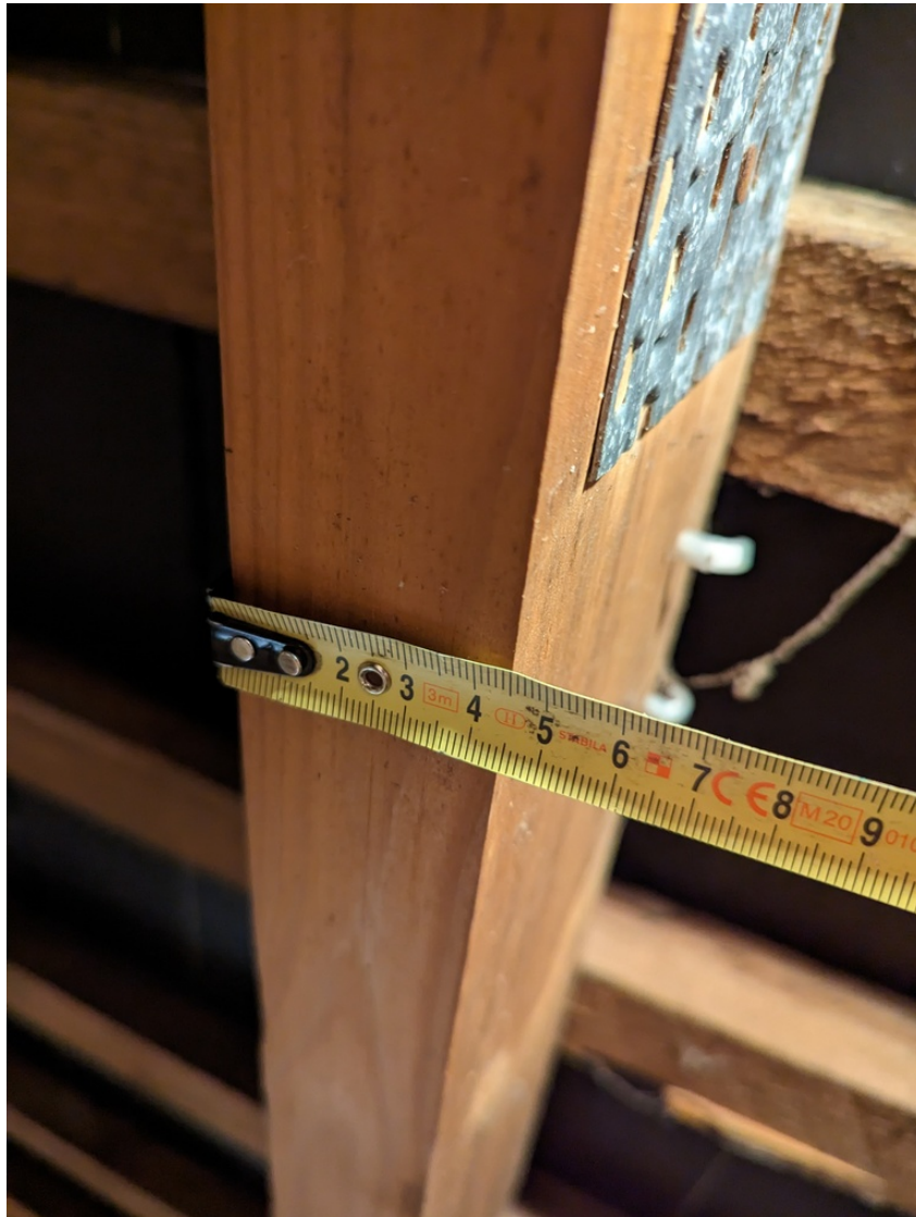
Figure 17: Spær bredde 4,5cm
