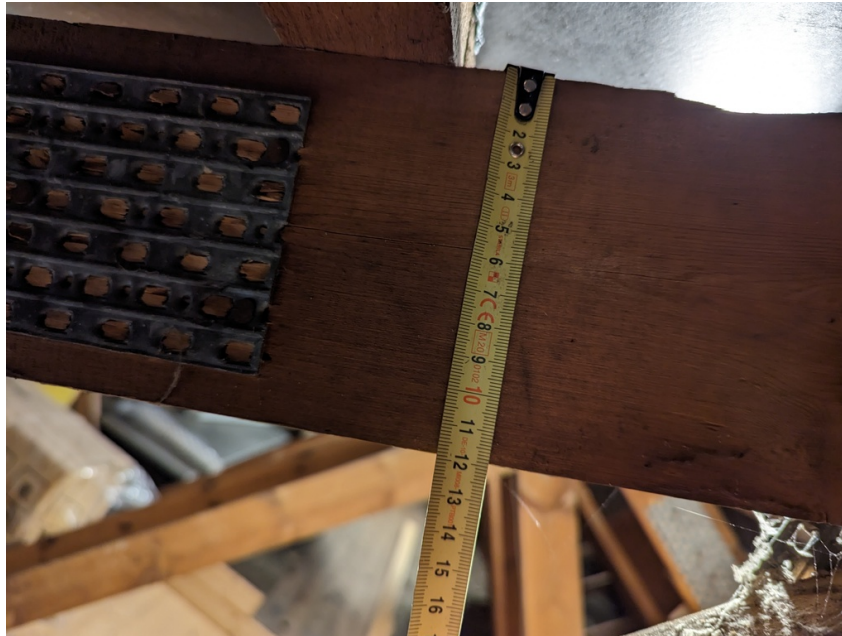
Figure 16: Spær som bærer tag direkte, 12cm tykkelse
