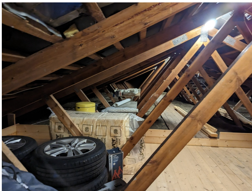
Figure 21: Detalje, gitterspær
