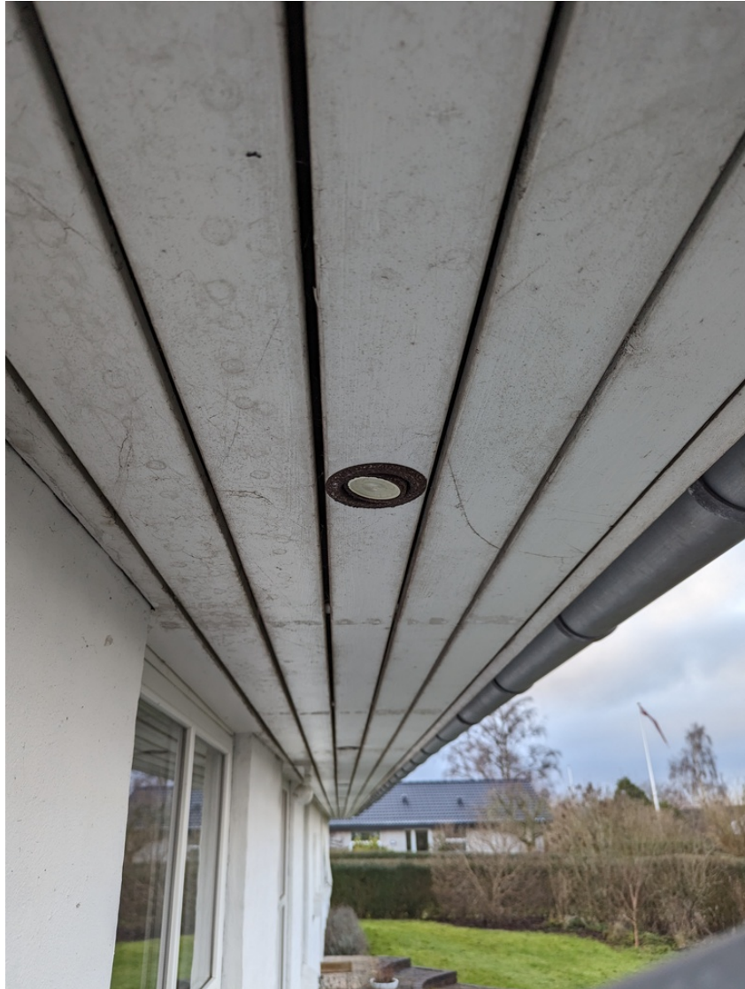
Figure 14: Detalje, underside af udhæng nordlige side
